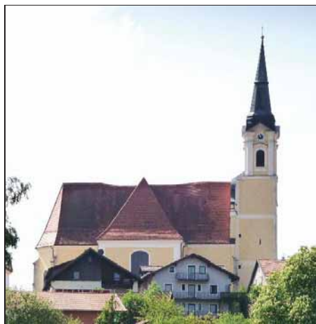
Abbildung 8: Im Jahr 1972 wurde die katholische Kirche in Untergriesbach mit Zyklon B begast. Anschließend verfärbte sich der gesamte Verputz fleckig blau (Konrad Lackerbeck; Wikipedia commons).
