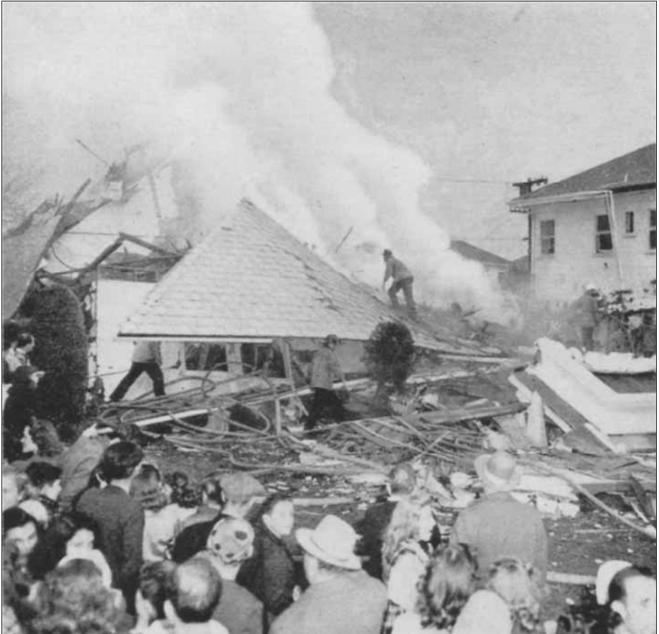
Abbildung 5: Wie man Termiten nicht loswird: Die angewandte Blausäurekonzentration war zu hoch. Ein einziger Funke, und das ganze Haus flog in die Luft.
